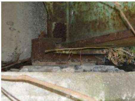
鋼桁の腐食
