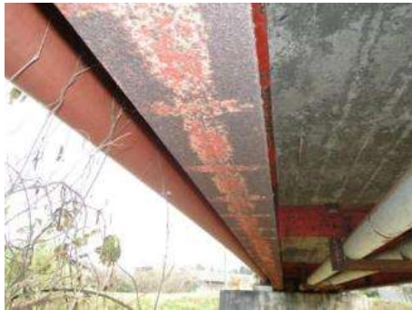
鋼桁の腐食
