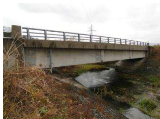
コンクリート橋
